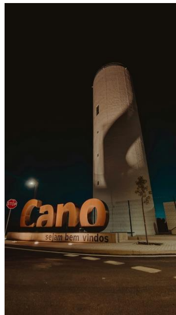
Imagem n.º 4- Deposito de água
