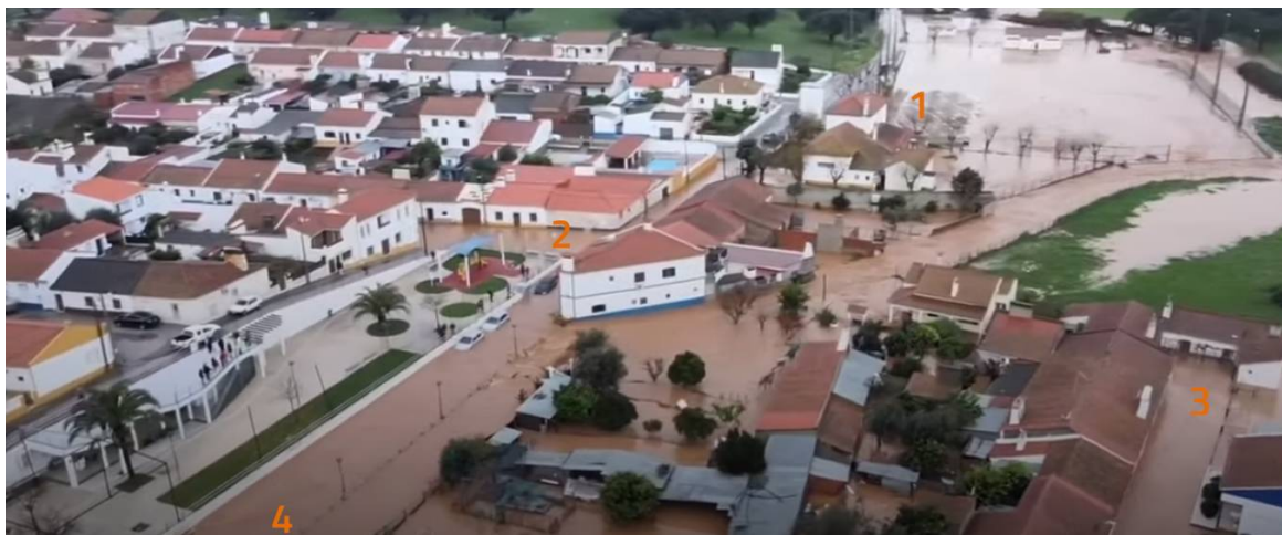
Figura 3.2.16. Vista geral da área inundada
